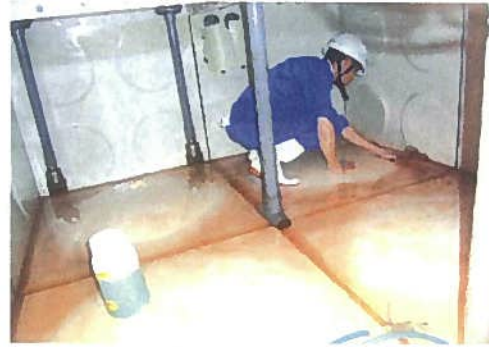
貯水槽内清掃の様子
