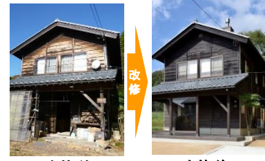
改修前 (空き家)
